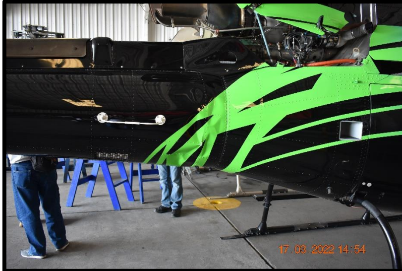
Fotografía No. 3 Vista de las rugosidades en el botalón de cola.
