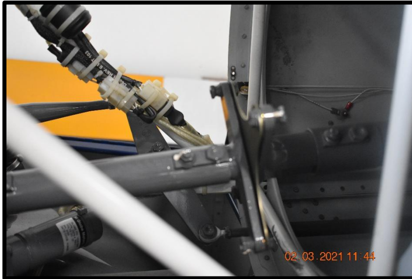
Fotografía No. 11 Vista de la transmisión del rotor de cola.
