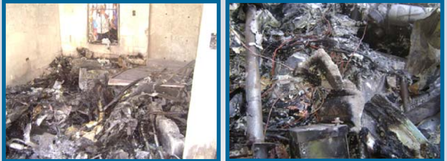
VISTA DEL INTERIOR EN DONDE CAYO EL HELICÓPTERO TOTALMENTE DESTRUIDO
